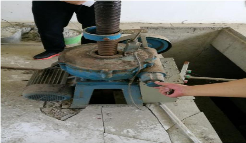
螺杆启闭机限位器及行程开关损坏,电动启闭系统无法使用
