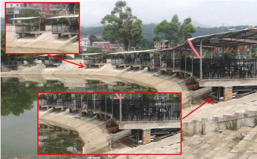
开挖上游坝坡及防浪墙建设餐饮平台支撑基础
