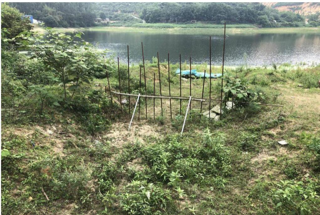
溢洪道入口被铁栅栏封闭
