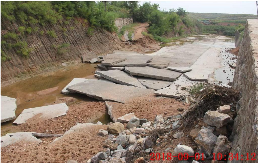
溢洪道底部混凝土面板被冲毁
